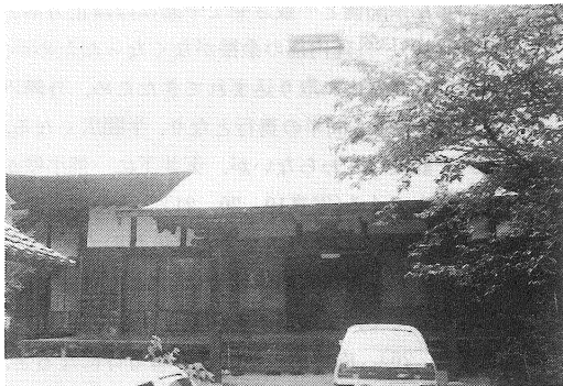
写真18 妙用寺本堂正面（東面）
