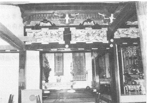
写真6 通順寺本堂南余間前の外陣
