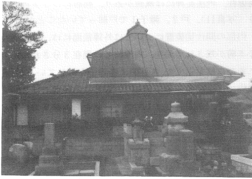
写真3 通順寺本堂南側面からみた下屋庇
