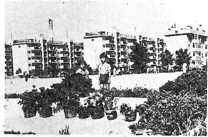
図12 Hangang 分譲アパート
