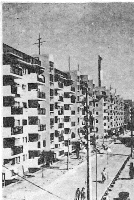
図11 Hangang 分譲アパート
