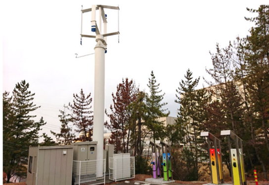
直流スマートファクトリ実験装置
