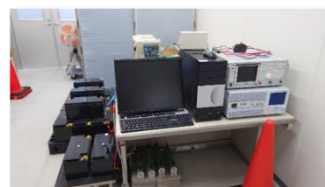
蓄電池再生試験
