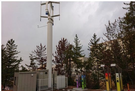
直流スマートファクトリ実験装置
