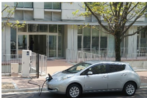
新 2 号館前での EV 給電の実験風景
