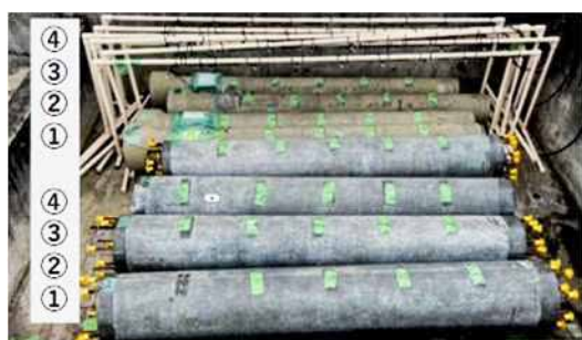
写真3 塩水噴霧による劣化促進のヒューム管と2m電柱の状況
