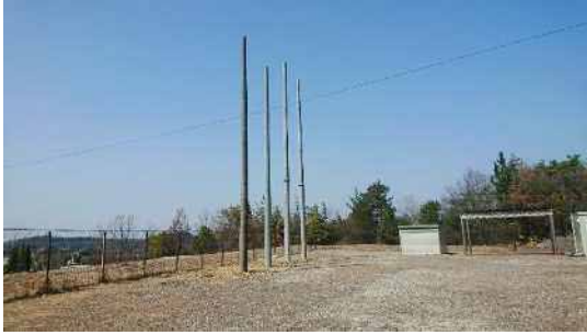
写真 5 北校地に建柱した電柱
