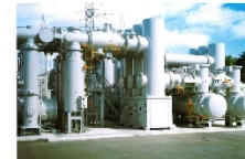
電力機器 (550 kV GIS) ※ ※株式会社東芝、「送電電機センサ」東京横浜工場に案内、パンフレット、No.8010-9、p.9 (2005)
