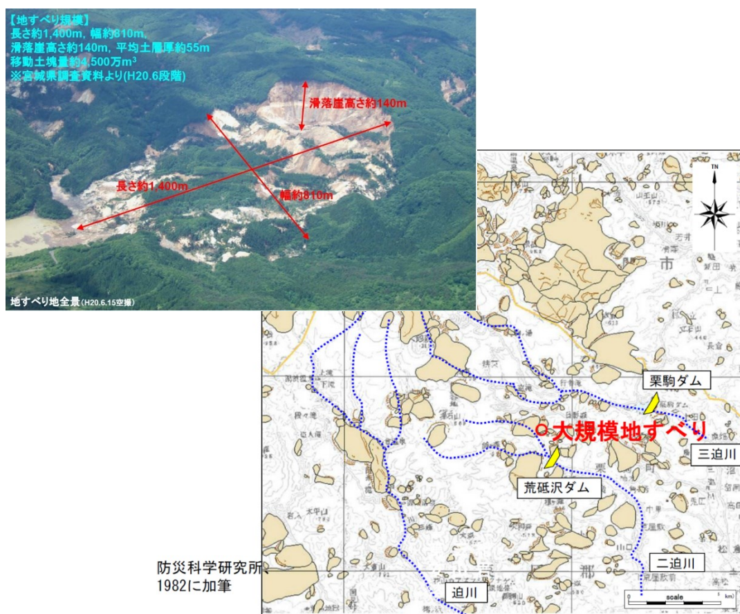
図18 荒砥沢ダム周辺で発生した大規模な地すべりの状況
