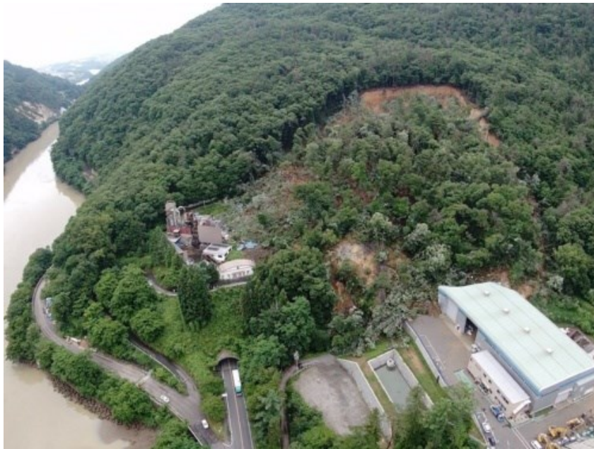
図 3 2021年7月に発生した小松原地すべり（長野市）
