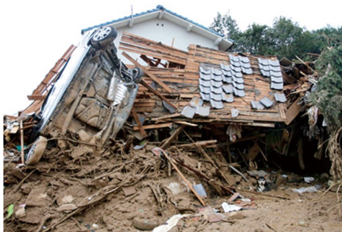
図9 被災した家屋の状況 [9]より引用
