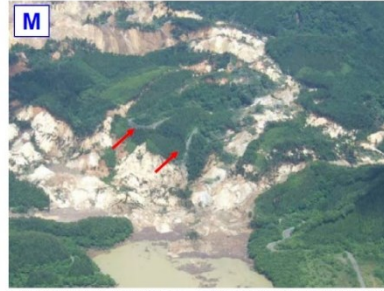
M 土塊内部に取り残された道路 (H20.8.9撮影)
