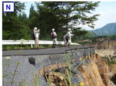
N 頭部滑落崖の寸断された道路 (H20.8.9撮影)
