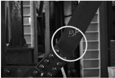
(c) ブレース材(B)の接合部付近の変形
