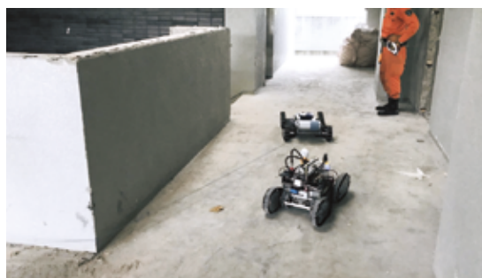
図3 中継ロボットによる通信ケーブル敷設の様子
