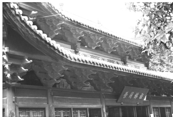
写真5-2 温泉寺接引殿・背面斗拱
