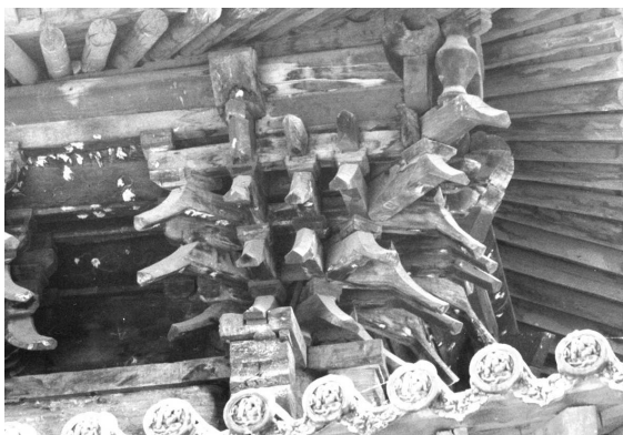
写真4-18 4. 報恩寺華嚴殿・主屋隅斗栱
