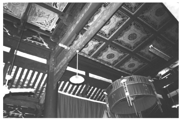
写真 5-4 温泉寺接引殿・内部架構 2
