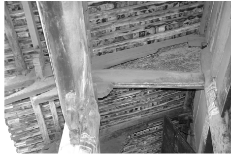
写真 3-18 4. 永安寺大殿·尾垂木尻
