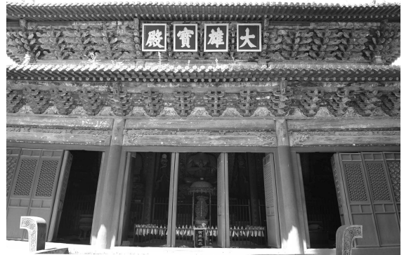
写真5-10 報恩寺大雄宝殿・正面斗栱
