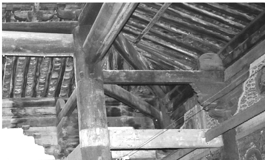
写真3-5 15. 宝梵寺大雄宝殿・柱上繫梁 (庇一架系：四面一架)
