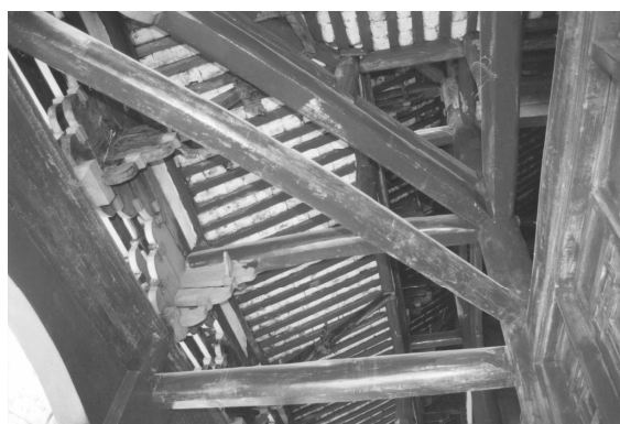
写真 5-8 温泉寺大雄宝殿・内部架構 2
