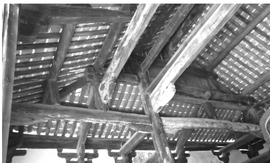
写真3-9 7. 磐陀寺大殿・主屋三架
