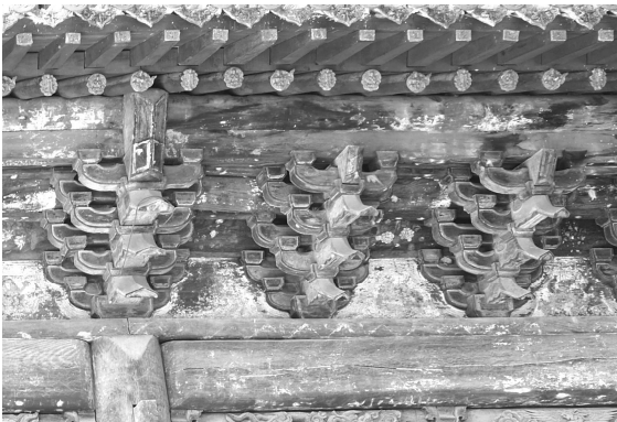
写真5-27 報恩寺大雄宝殿・裳階正面斗栱
