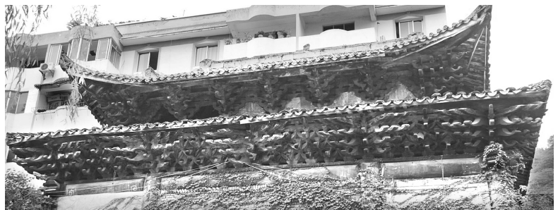
写真4-22 8. 万寿観玄祖殿・裳階正面如意斗栱（「二葉栱」と「斜栱」）
