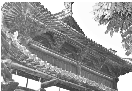
写真 5-25 観音寺羅漢殿・主屋側面斗栱
