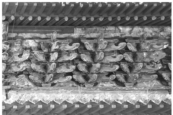
写真5-30 報恩寺大雄宝殿・主屋正面斗栱
