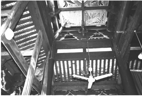
写真 5-3 温泉寺接引殿・内部架構 1
