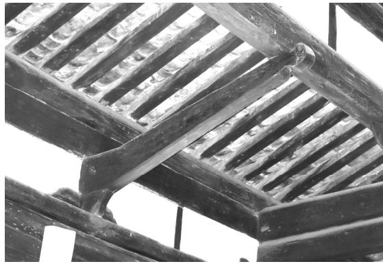
写真 5-39 観音寺羅漢殿・裳階持出梁後部
