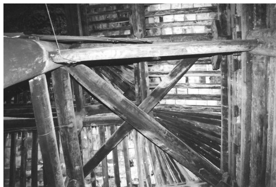
写真4-8 3. 甘露寺正殿・火打梁
