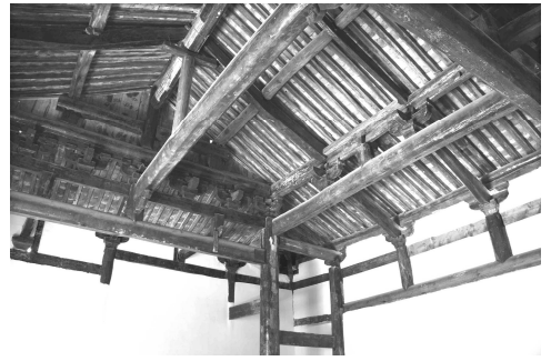
写真 3-14 1. 花林寺大殿·屋根裏大型登梁
