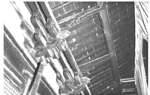
写真 3-17 13. 龍居寺中殿·庇小型登梁
