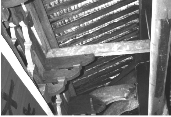
写真 5-37 温泉寺接引殿・裳階側面尾垂木尻
