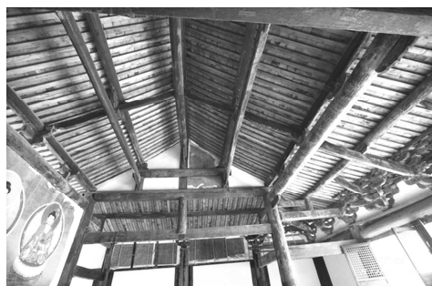
写真3-11 2. 青龍寺大殿・屋根裏大型登梁
