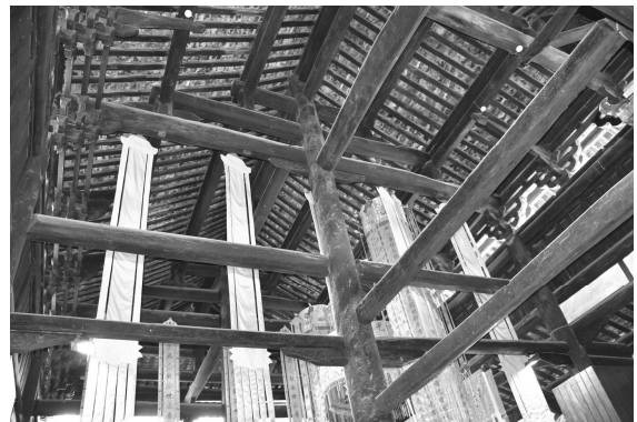
写真5-16 観音寺羅漢殿・内部架構
