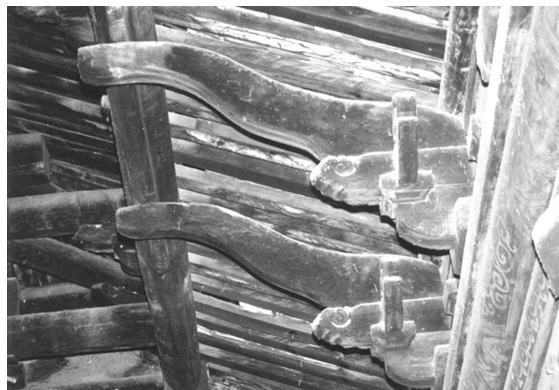
写真 4-15 3. 甘露寺正殿・裳階中備斗拱尾垂木尻
