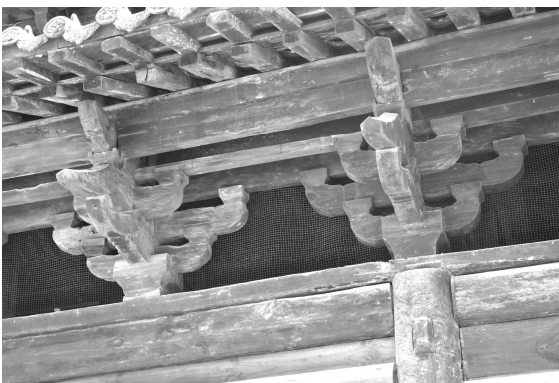
写真5-29 観音寺大雄宝殿・裳階背面斗栱
