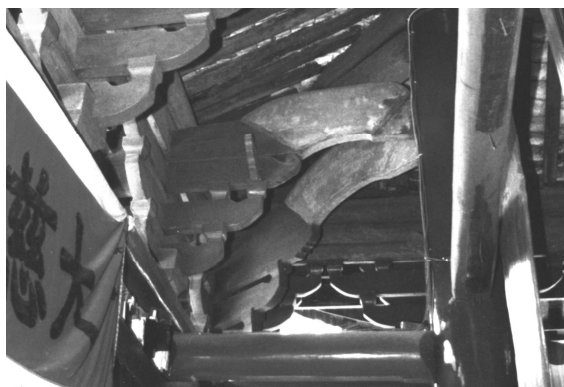
写真5-23 温泉寺大雄宝殿・裳階柱上斗拱内側
