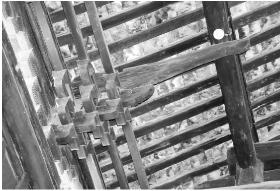
(1) 主屋正面尾垂木尻
