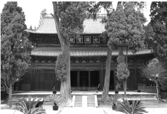
写真5-9 報恩寺大雄宝殿・外観
