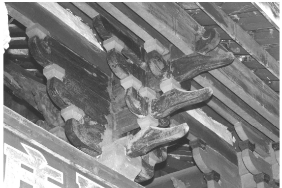
写真5-28 温泉寺大雄宝殿・裳階正面斗栱
