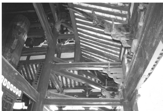
写真5-21 温泉寺大雄宝殿・裳階繫梁架構
