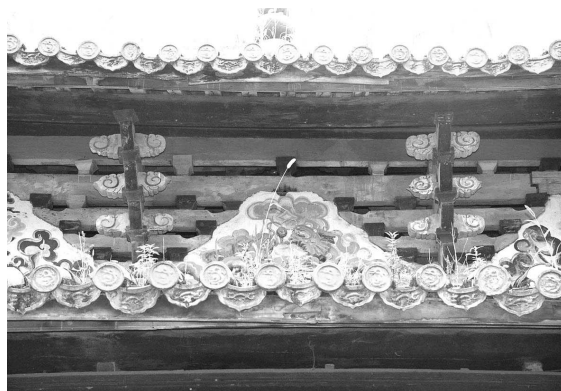
写真 4-12 10. 万寿寺大雄宝殿・主屋正面斗栱
