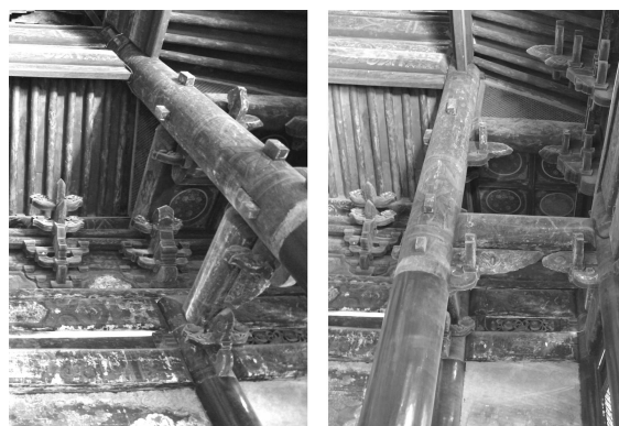
写真5-22 報恩寺大雄宝殿・裳階繫梁架構
