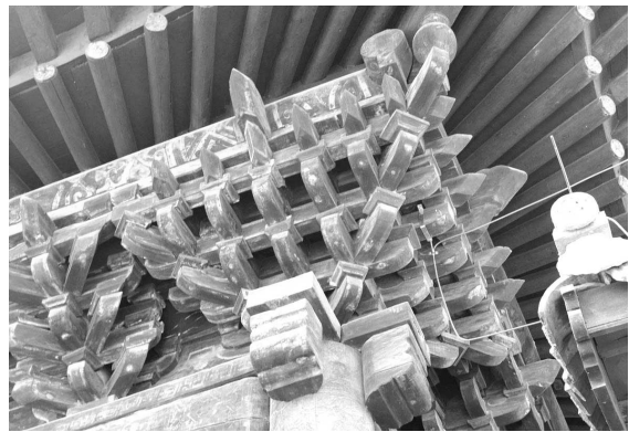
写真4-17 4. 報恩寺華嚴殿・裳階隅斗栱
