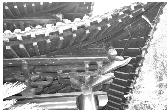
写真4-4 1. 宝輪寺大雄宝殿・扇垂木
