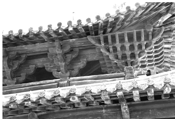
写真 5-26 観音寺大雄宝殿・主屋背面斗栱
