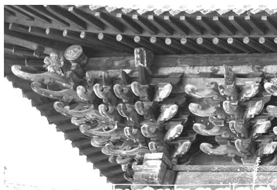
写真5-31 報恩寺大雄宝殿・主屋隅斗栱
