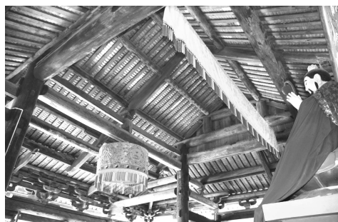
写真3-12 3. 報恩寺三清殿・屋根裏大型登梁
