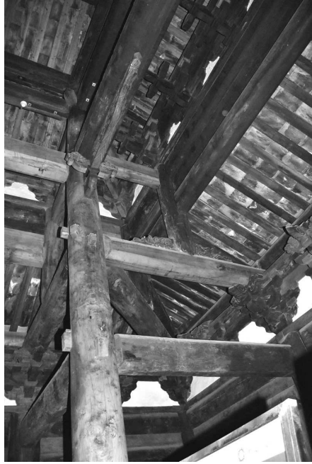
写真4-5 5. 観音閣正殿・主屋柱と裳階柱間の架構
