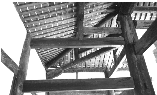
写真3-7 2. 青龍寺大殿・柱上繫梁 (庇二架系：四面二架)
