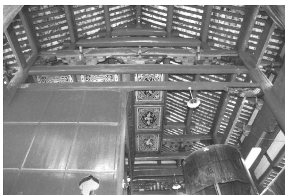
写真 5-7 温泉寺大雄宝殿・内部架構 1
