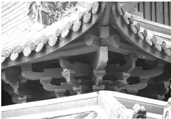
写真4-16 12. 斗栱宮慈航殿・主屋隅斗栱
