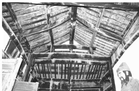
写真3-13 5. 五龍廟文昌閣・屋根裏大型登梁
