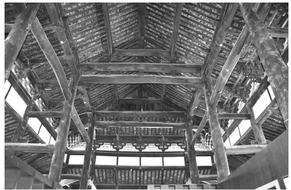
写真5-20 観音寺大雄宝殿・内部架構
