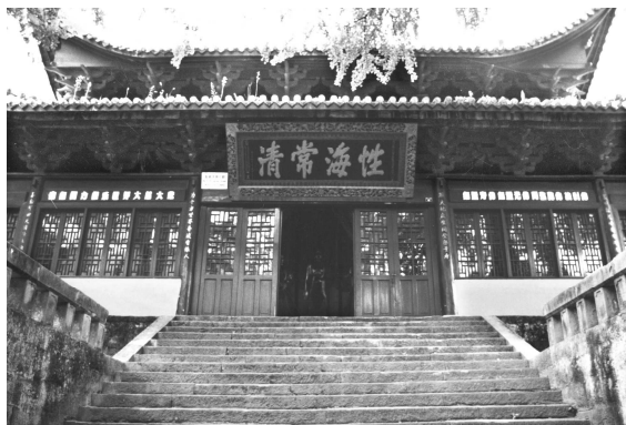
写真5-1 温泉寺接引殿・外観
