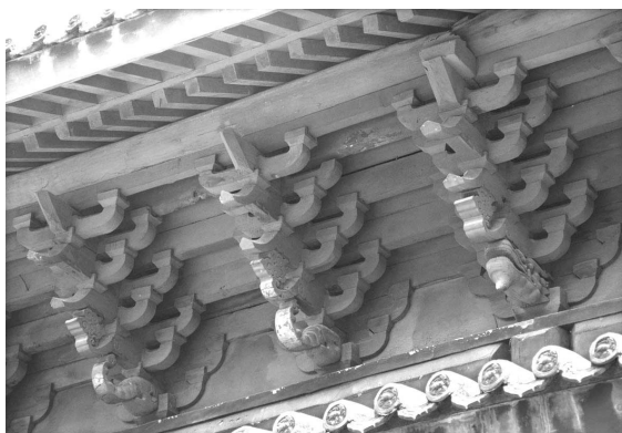
写真 4-11 7. 灵泉寺大雄宝殿・主屋正面斗栱
