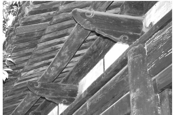
写真5-14 観音寺羅漢殿・裳階持出梁
