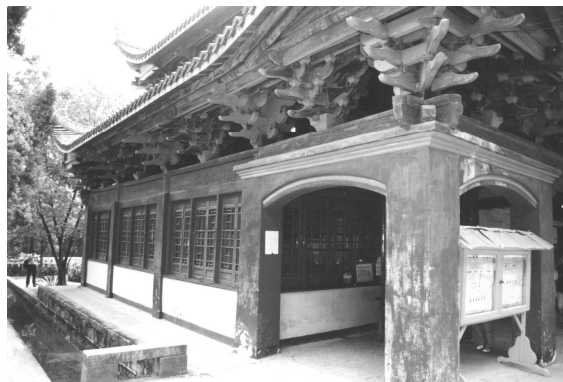
写真 5-6 温泉寺大雄宝殿・側面斗栱
