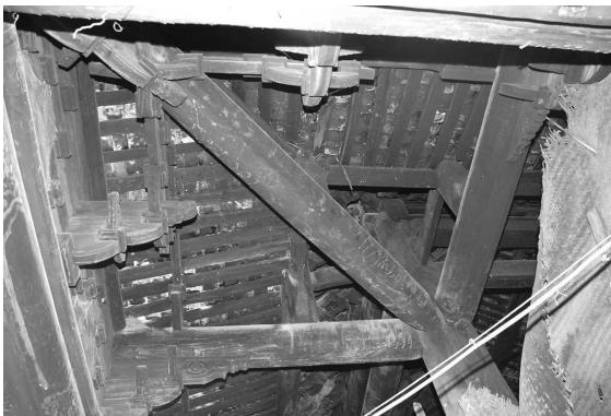
写真4-6 2. 万寿寺観音殿・真隅
