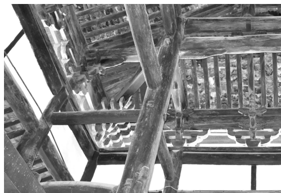
写真5-24 観音寺大雄宝殿・束繫梁
