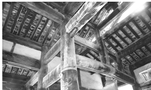
写真3-8 20. 文星廟正殿・柱上繫梁 (庇三架系：四面三架)
