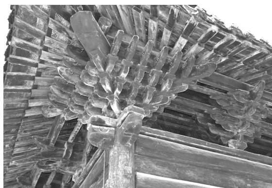
写真5-32 観音寺大雄宝殿・裳階隅斗栱
