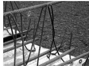
写真1 試験体崩壊状況 (H260-13-13-5)
