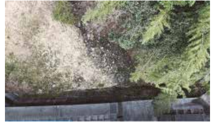
図-5 堰堤内点検（ドローン）
