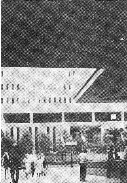
エリヤ14公園より連邦政府事務所ビルをみる
