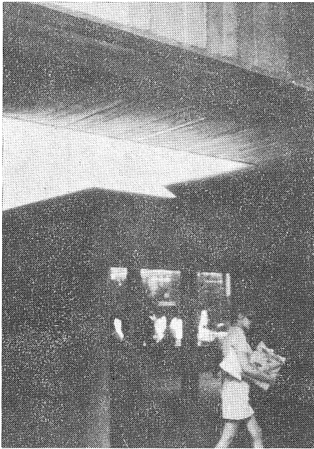
ボルチモア・チャールズセンター歩車道分離 (ペデストリアンデッキをみる)
