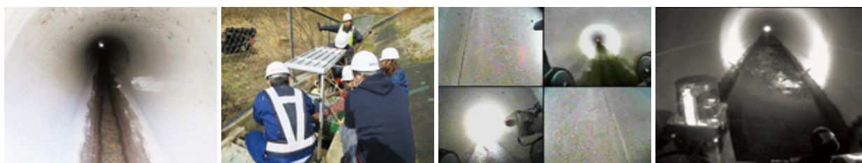
図7 カルバート内点検検証実験の様子（2017年3月1日）
