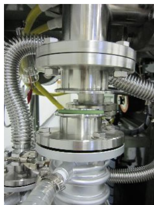
図 8 クランプを外した配管
