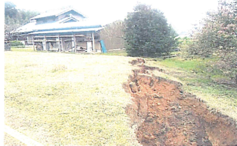
図8 岐阜県御嵩町で発生した広域陥没事故の様子
