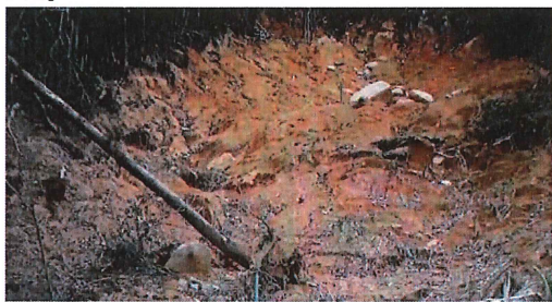
図 11 地上カメラから撮影した災害状況
