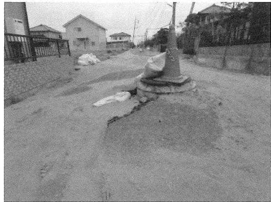
写真2 道路中央のマンホール
