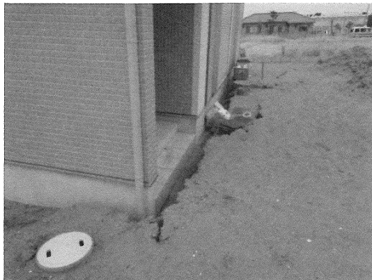
写真5 液状化で傾いた住居
