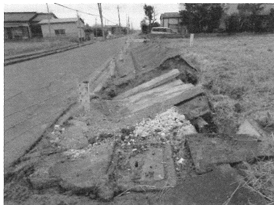
写真4 道路の陥没
