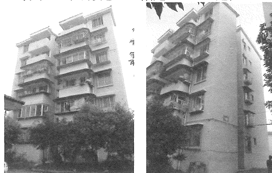
写真3 健全な6階建てレンガ造住宅C
