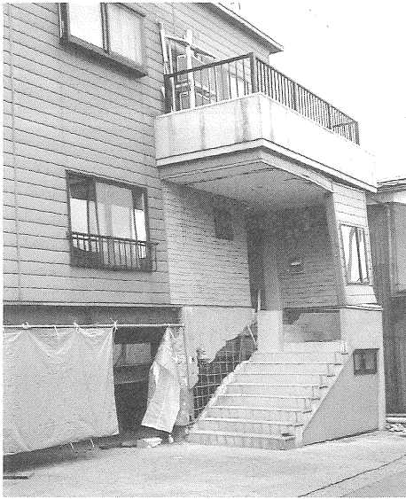
写真7 S造3階建物全体（小千谷市）
