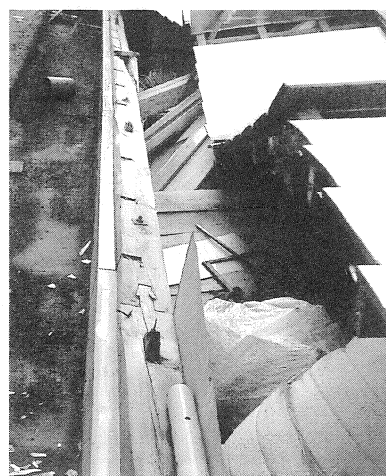
写真4 写真3建物の土台
