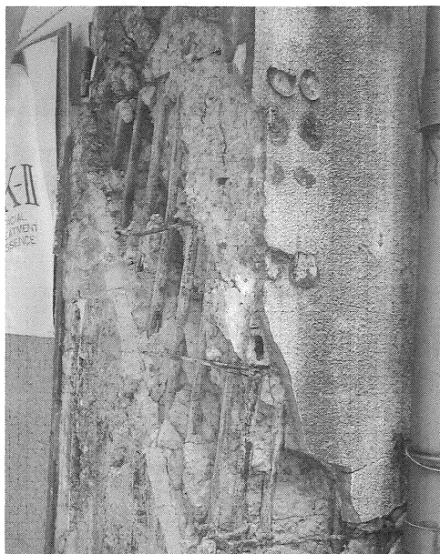
写真 10 RC 造 4 階建て 1 階柱の破壊 (十日町市)
