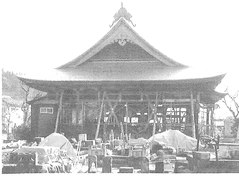
写真5 寺本堂の倒壊防止補強（川口町）
