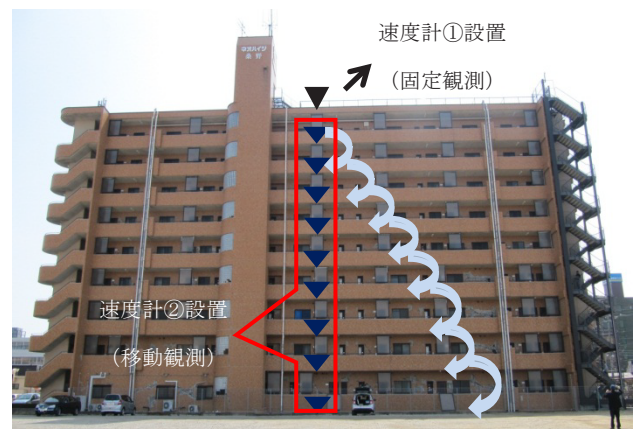
写真4 郡山市桑野ネオハイツ集合住宅観測現場状況
