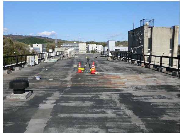
写真-1 受信機設置場所 (本学 2 号館屋上)
