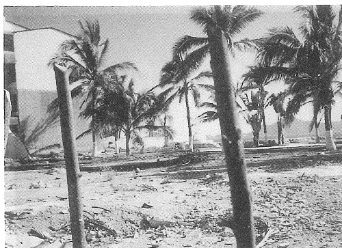
写真7 マンサニージョのホテル・コスタの倒壊により多くの死者が出た。撤去後(1年後)の現場風景。
